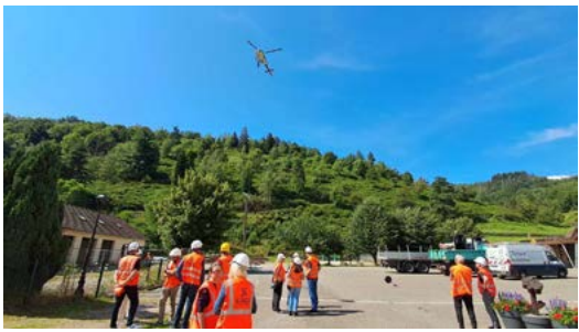
Démontage de l'ancienne ligne aérienne 20 KV par hélicoptère avec dépose sur la place des fêtes
