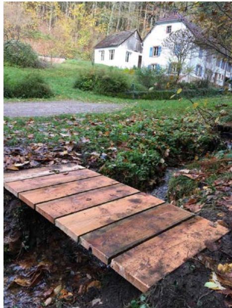
Réfection du pont sur le ruisseau de la Vaurière par Didier Graff et Antoine Hinsinger
