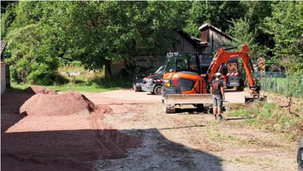
Travaux de réfection du parking de la scierie
