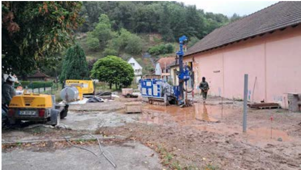
Mise en place de pieux rendue obligatoire avec les nouvelles obligations de sondage de sol
