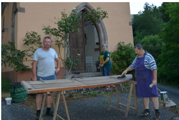
Ponçage et remise en peinture de la porte de la chapelle de la Hingrie.
