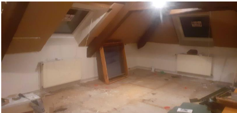
Poursuite de la rénovation des locaux scolaires avec changement des vélux, des sols et isolation.
