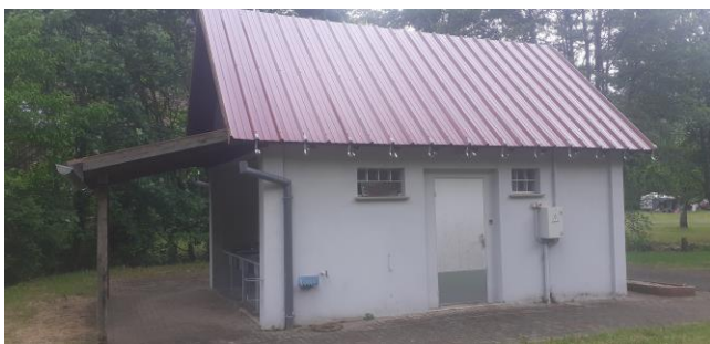
Remplacement des anciennes tuiles par des bacs aciers empêchant la prolifération des mousses et les infiltrations bien adaptés pour les faibles pentes.
