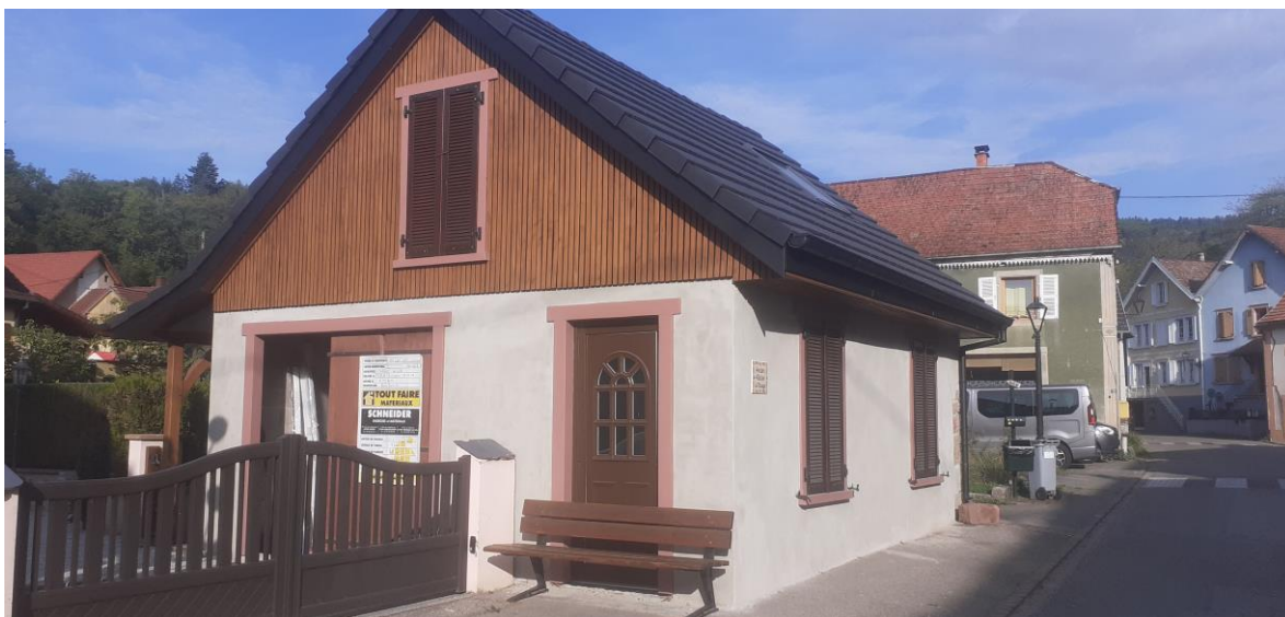
Rénovation des anciens ateliers textiles : une première opération s'est faite avec la rénovation de l'atelier de M Feil avec une aide de 3000 € de la commune.
