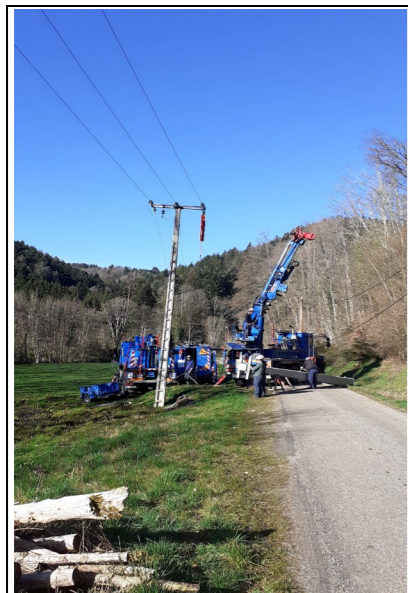
Pose du poteau aéro-souterrain en amont du camping. La ligne située en aval sera démontée en totalité courant printemps 2022.
