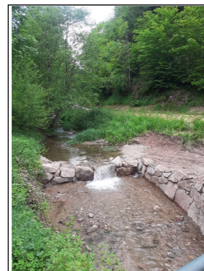
Réparation d'un passage à gué et consolidation de rive en enrochement sur le Rombach
