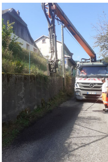
Gravillonnage route de la Hingrie
