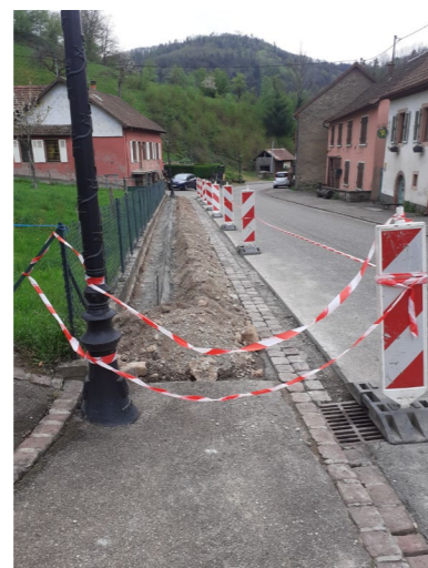
Réfection de trottoirs rue de Naugigoutte
