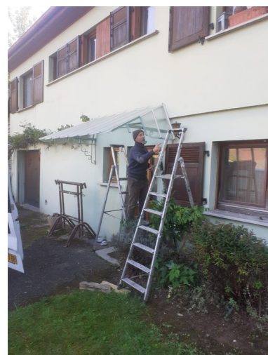
Réfection de la marquise de la maison forestière en régie communale
