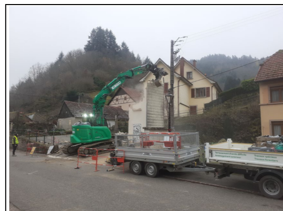
Démolition du poste de Hargoutte fin novembre. Les postes de la Biaise et du Chambi vont suivre prochainement.
